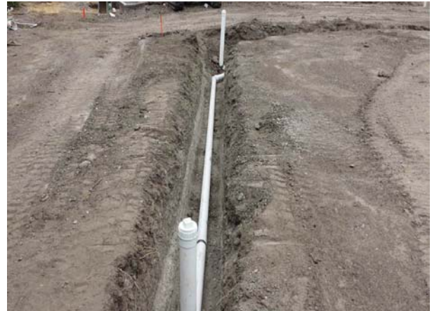
Sewer & DI Tie-in
